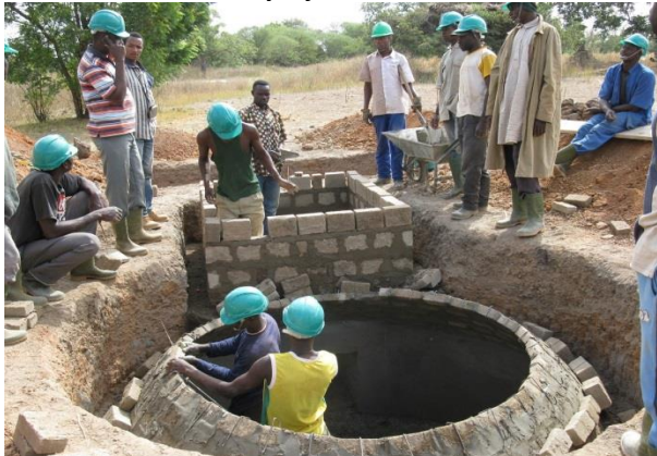
constructie van een biogas-reservoir
