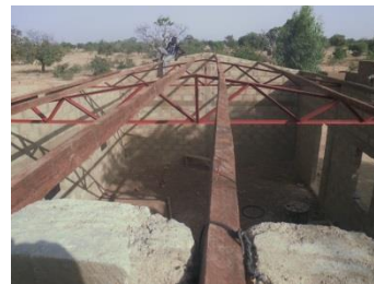
Een nieuw dak wordt geplaatst
