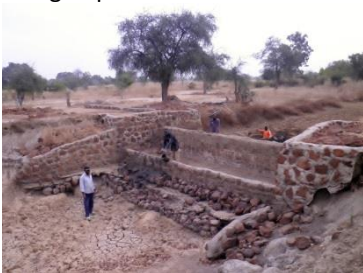
zanddam gebouwd met hulp SVIK Dirksland
