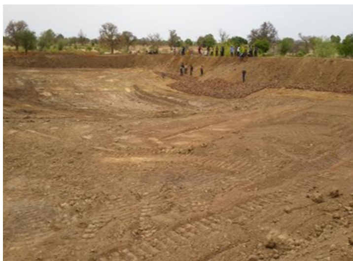
Het waterbekken van 40.000m 3 nadert zijn voltooiing
