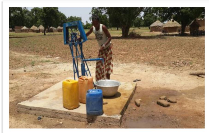
Een pomp met een capaciteit van 100 liter per minuut
